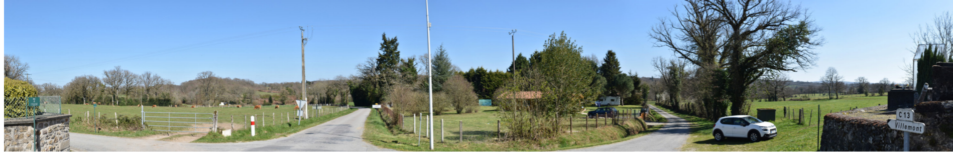
Point de vue initial : entrée ouest de Saint-Priest-le-Betoux sur le D93 - Éolienne la plus proche : 3.916 km. Intérêts : urbanisme proche. Angle de vue : 162.3°
